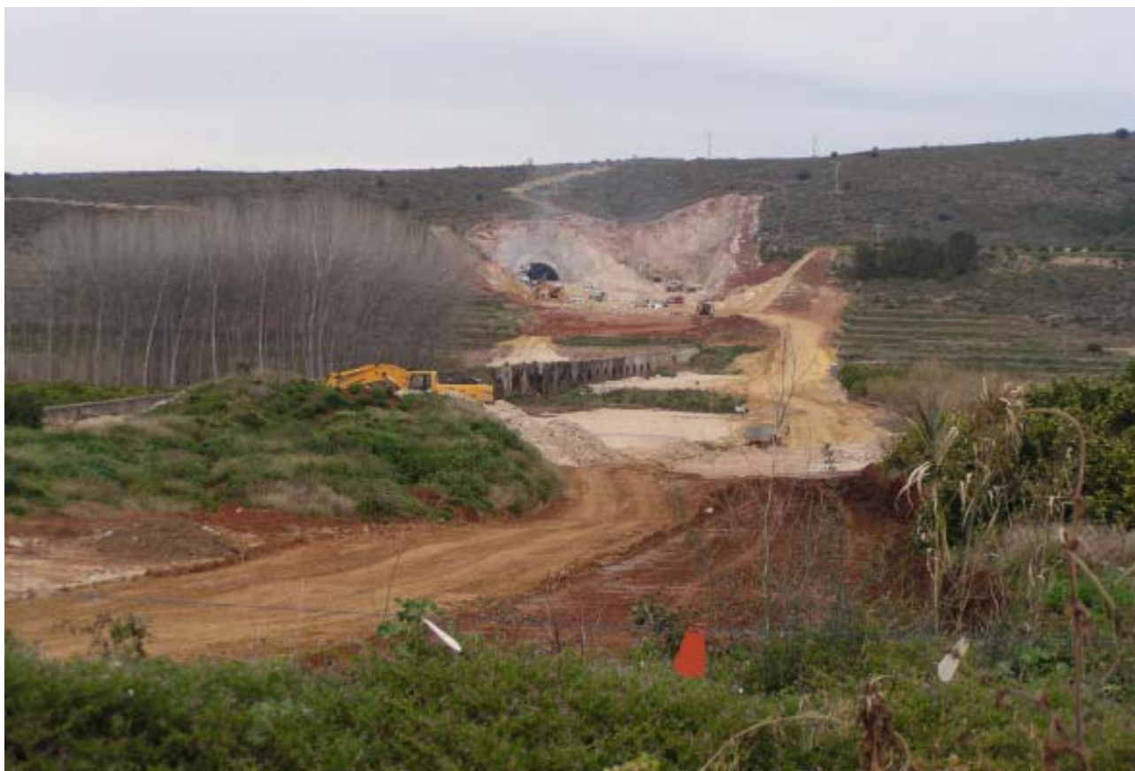
Aqueducte de la Torre d'en Lloris abans de construir-se, sobre el barranc de Barxeta, una plataforma per a l'AVE
