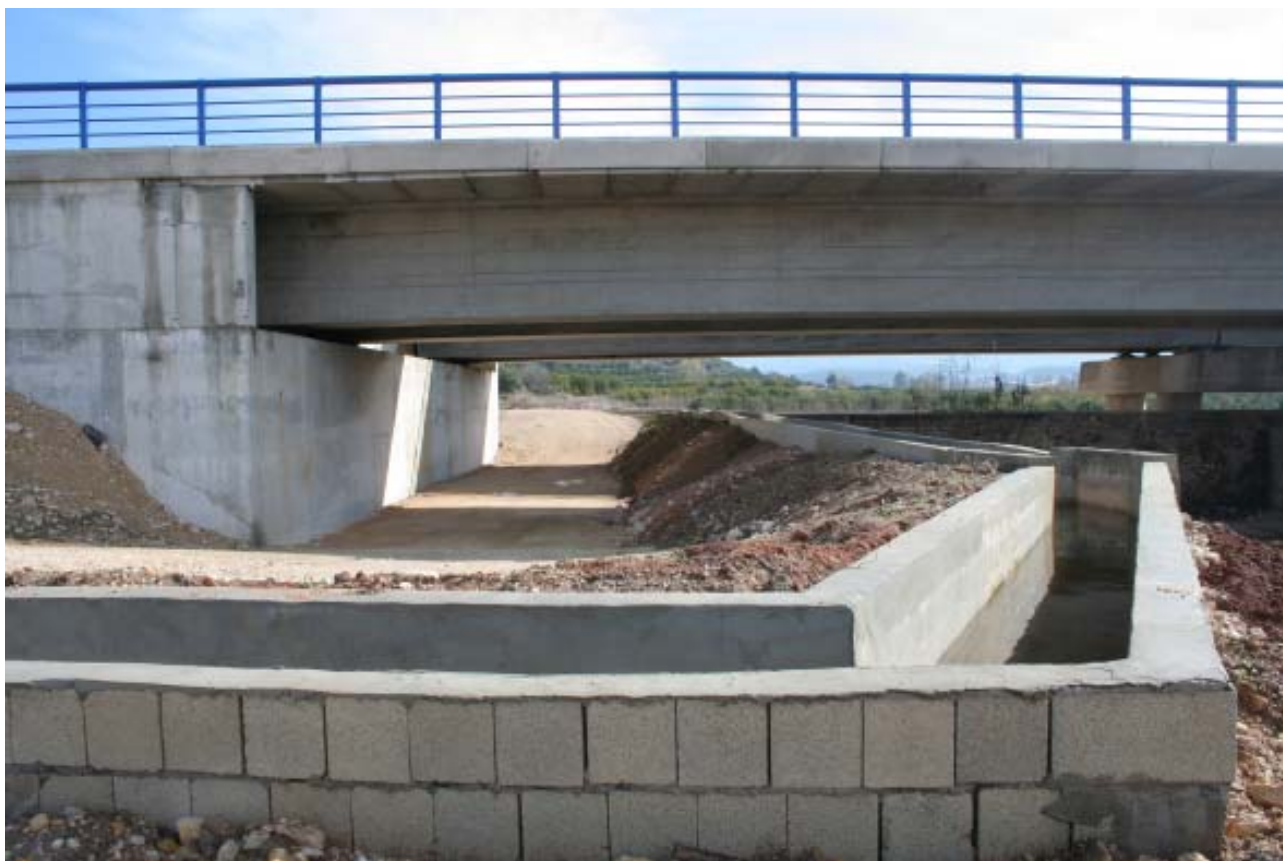
Elements de l'arquitectura de l'aigua, en aquest cas la sèquia de la Torre d'en Lloris, han hagut de ser modificats a causa del traçat de l'AVE
